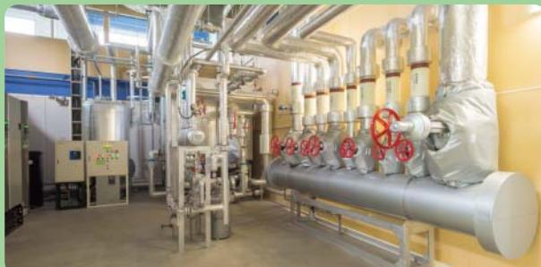
本体のみでなくバルブまで断熱材を巻き付けることで断熱効果を上げる
