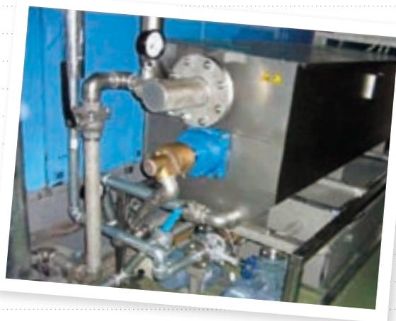
EMSローターは、洗濯排水からの余熱を回収してすすぎ用の水の温度を上げるのに使うシステム（小樽工場）
